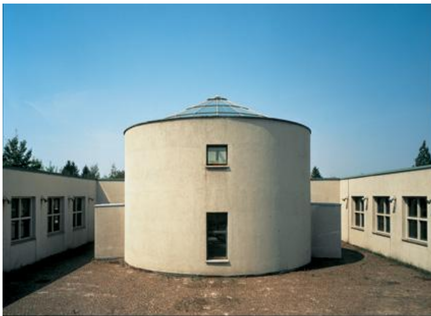
A. Rossi, Scuola elementare "Salvatore Orrù", 1972-1976, Fagnano Olona, particolare della biblioteca. © Eredi Aldo Rossi. Photo Palladium - Barbara Burg + Oliver Schuh | Architectural Photographers
